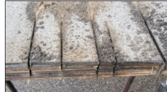
Bitumen- mit viel Wasser
