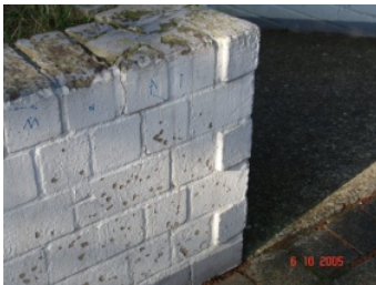
Beton und Stein- im Einblattbetrieb
